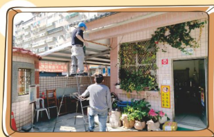
更換大門警衛室遮雨棚(施工中)。
