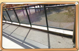
檢視校內安全設施檢修改善。
