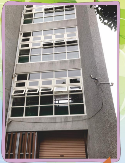
至善樓南面遮雨窗外觀，防強風防潑雨，維持樓梯平台地面乾燥，促進行走安全。
