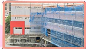
教學大樓工程進行順利
