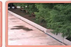
完成落羽松下的矮牆及小水溝設置間隔停車區及暢通水道
