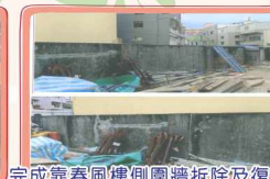
完成靠春風樓側圍牆拆除及復原工程後讓校園安全維護更有保障
