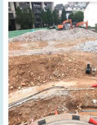
舊有春風樓基地之原有建築物已拆除
