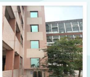
新民樓電梯工程完成側面圖
