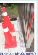
司令台音響設備間後加強防護
