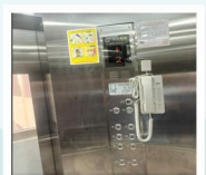
新民樓電梯工程完成內部圖
